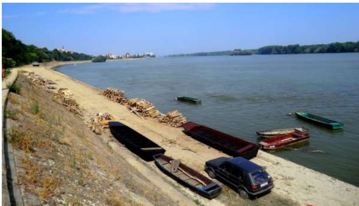
Slika 3.1 Sadašnje stanje akvatorija pristaništa ( pogled uzvodno s postojećeg navoza za čamce)
